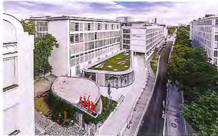
Das Städtische Berufliche Schulzentrum Thomas Wimmer an der Luisenstraße wurde saniert.
