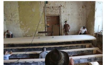
Einheben eines Deckenelements
