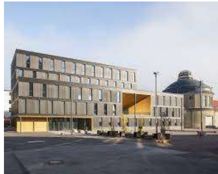
Musikbox Augsburg, Altes Gaswerk – Holzbau in 5 Etagen
