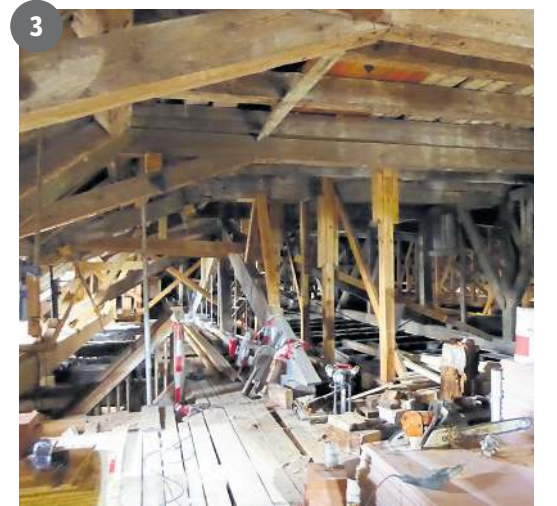
1: Einige der über 300 Jahre alten Deckenbalken im Schloss sind mehrfarbig bemalt und besonders erhaltenswert. 2: Im rechten Ostflügel von Schloss Steinort in Sztynort/Masuren befindet sich bereits ein kleines Informationszentrum. 3: Die Sanierung des Dachstuhls über dem Mittelbau ist derzeit noch eine der größten Herausforderungen, um ihm wieder seine volle statische Funktion und Tragfähigkeit zu geben ohne Stützkonstruktionen. Fotos: Michael Nicklas
