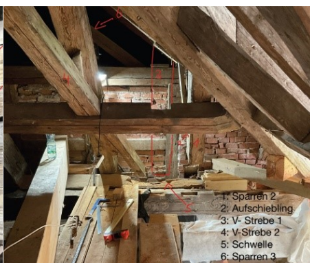
Komplexe Ecke: Kernbau Ost/Südseite am Gratsparrenfußpunkt
