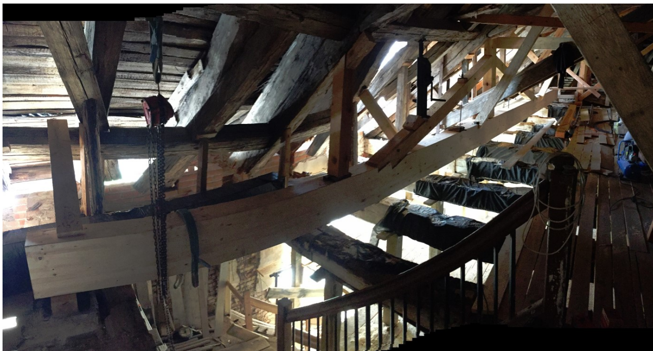
Das fertiggestellte Hängewerk an seiner endgültigen Position
