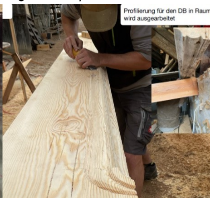
Profilierung für neuen Balken
