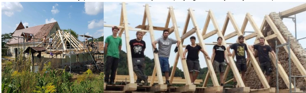
Zdjęcia naszej pracy i techników budowlanych w Transylwanii/Rumunii
