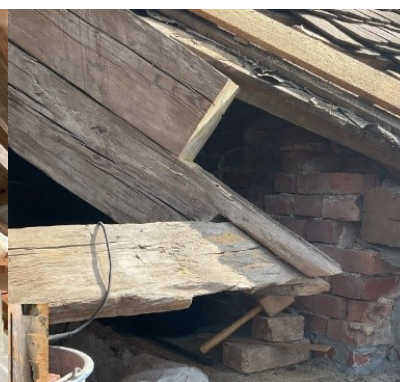
Komplexe Ecke: Kernbau Ost/Südseite am Gratsparrenfußpunkt
