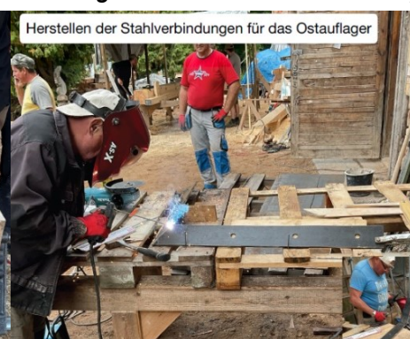
Schweißen der 3D-Stahllasche
