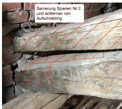
Bestand Sparren und Aufschiebling
