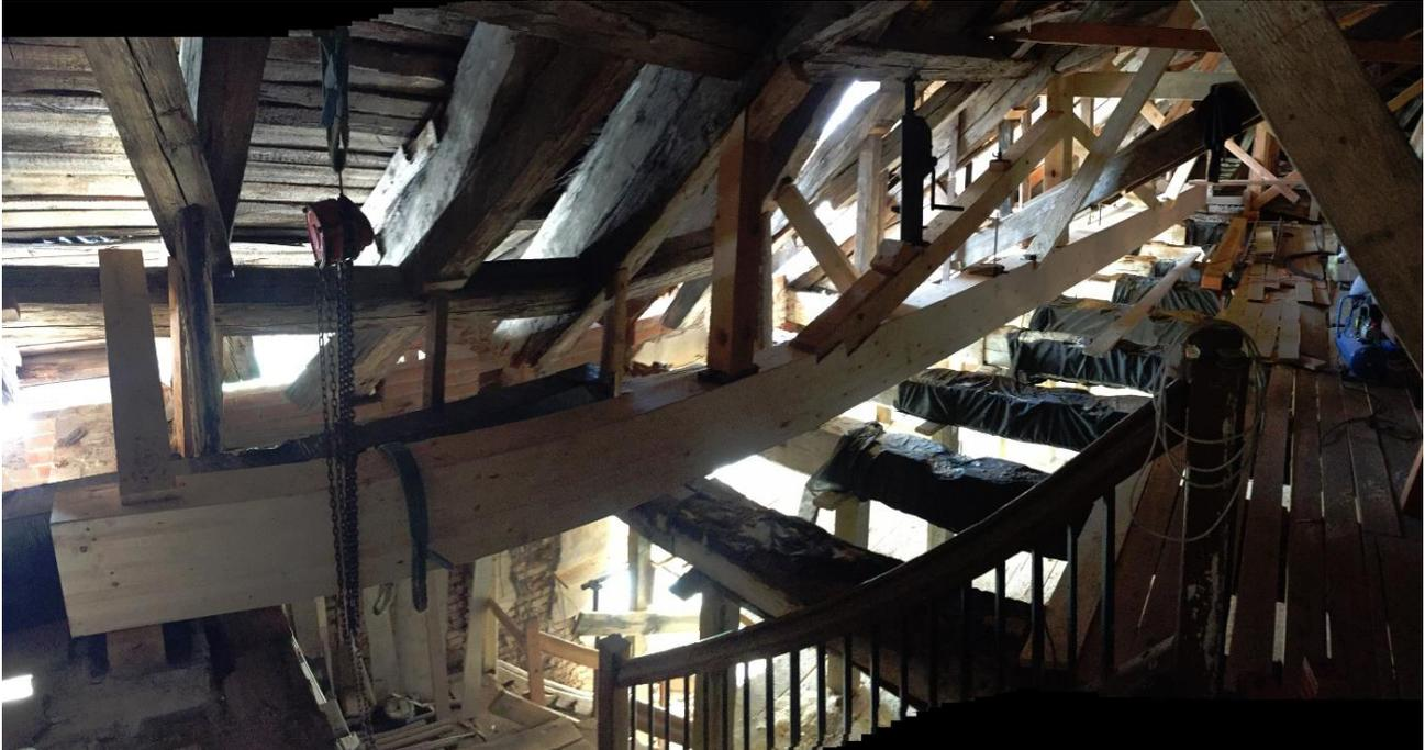
*Das fertiggestellte Hängewerk an seiner endgültigen Position*
