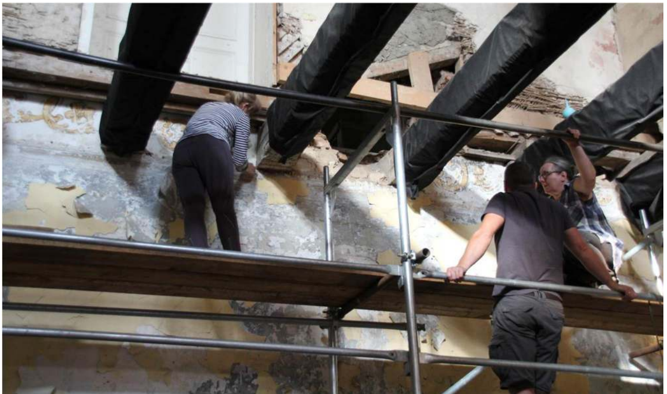
Bild 5 Die polychrome Bemalung der Decken und von Teilen der Wände ist und bleibt das Highlight des Schlosses. Deren Sicherung und Restaurierung hat deshalb oberste Priorität
