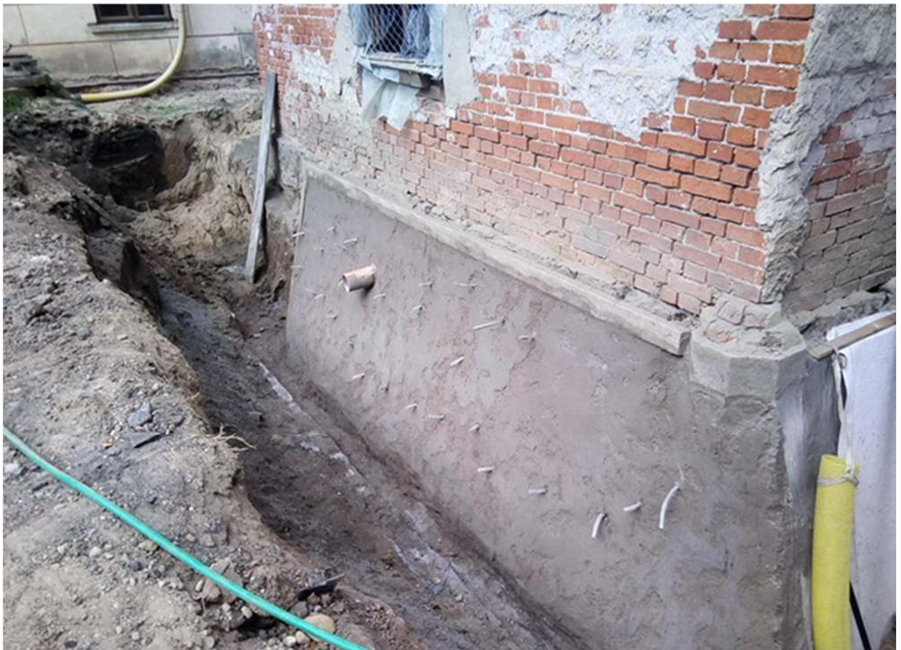
Bild 2 Sanierung der Fundamente (Nordost-Eckturm) - Arbeitsgang vor dem Verpressen
