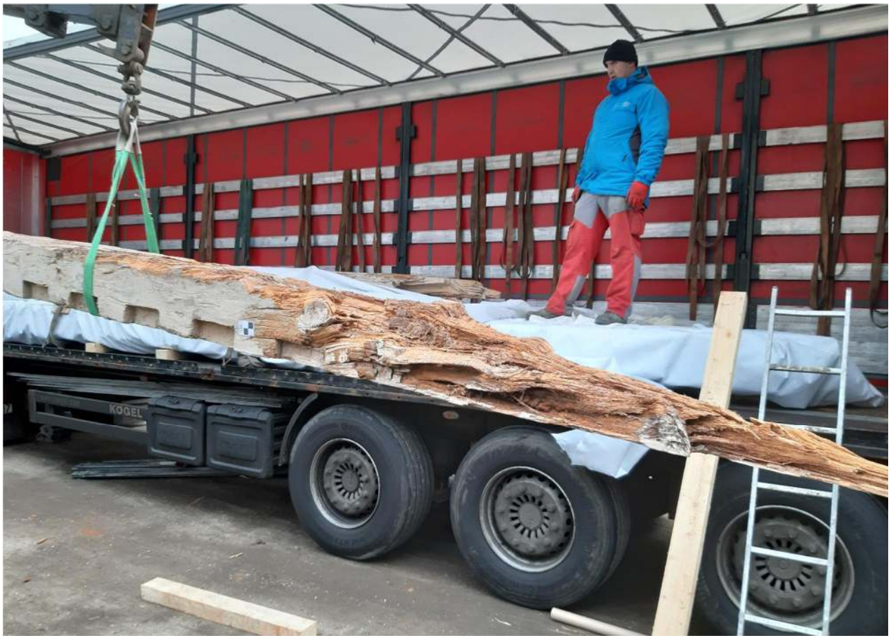
Bild 3 Verladen der Deckenbalken aus Raum 0.09 am 01.12.2020 (Foto: Janusz Dobrzynski)
