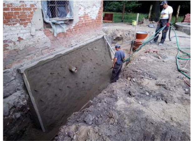
Bild 2 Injektion des Fundamentes am Ostturm des Kernbaus und Spritzschicht zur Aufbringung einer vertikalen Abdichtung
