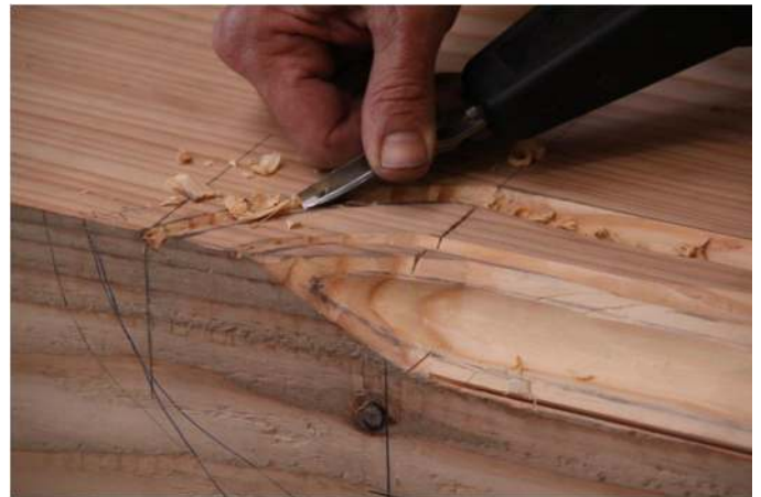
Bild 14 Schnitzprobe für das Profil eines zu ersetzenden Balkenkopfes
