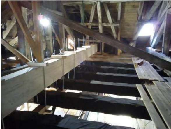
Bild 5 Vorübergehender Abfangträger, um die auszubauenden Deckenbalken über dem Erdgeschoss kraftfrei stellen zu können
