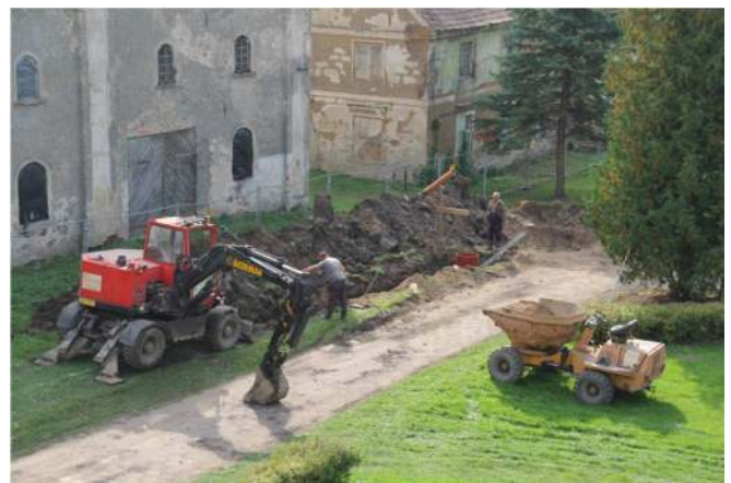
Bild 4 Endlich ist es gelungen, die Schmutzwasserleitung an die örtliche Kläranlage anzuschließen – wichtige Voraussetzung für eine Teilnutzung!
