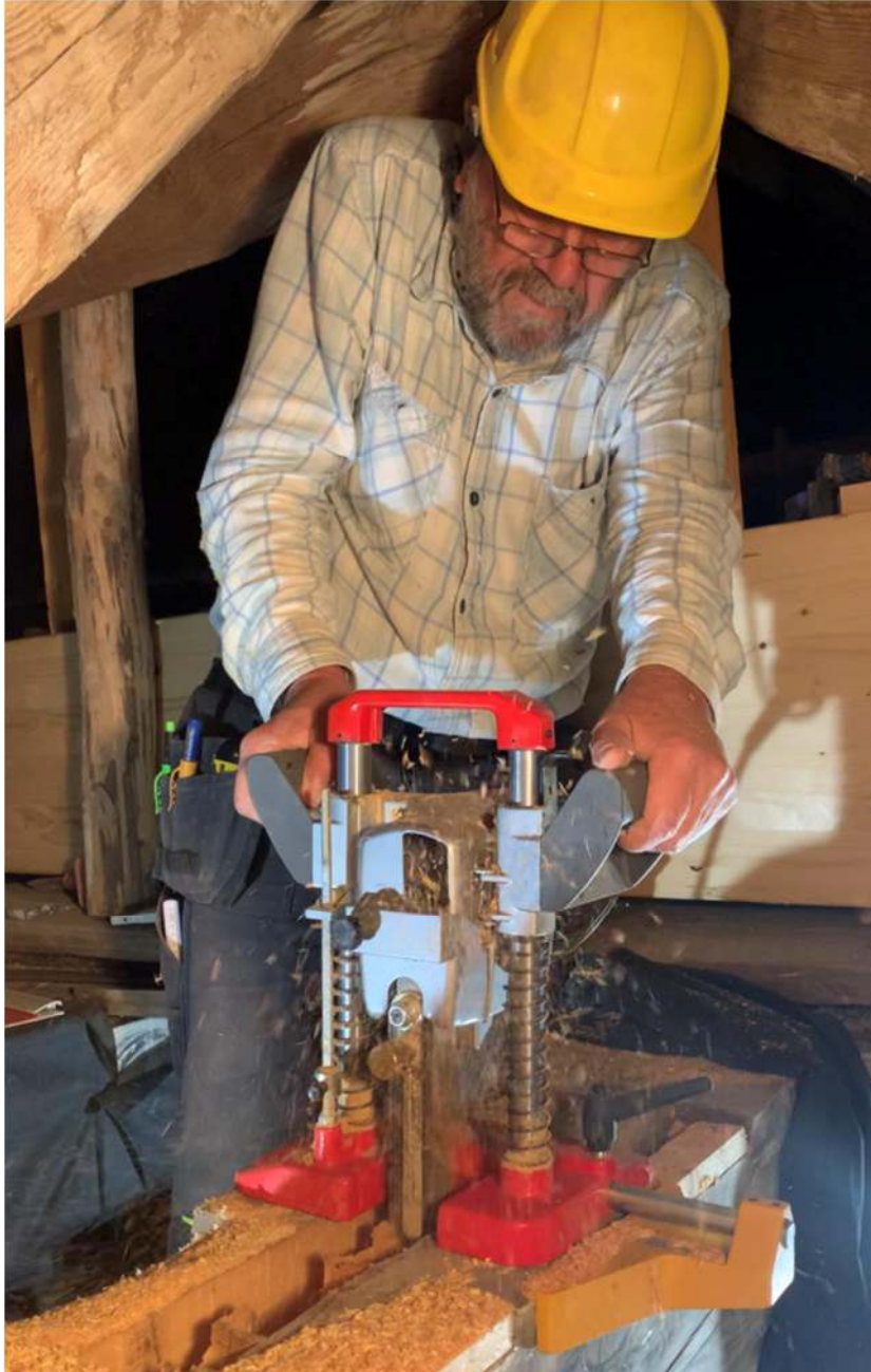
Bild 17 Grau ist alle Theorie der Denkmalpflege, Vormachen muss man es können! Hier zeige ich die Vorgehensweise bei der Balkenkopfsanierung im Schloss (als die Corona-Lage es mir noch erlaubte, nach Steinort zu reisen)
