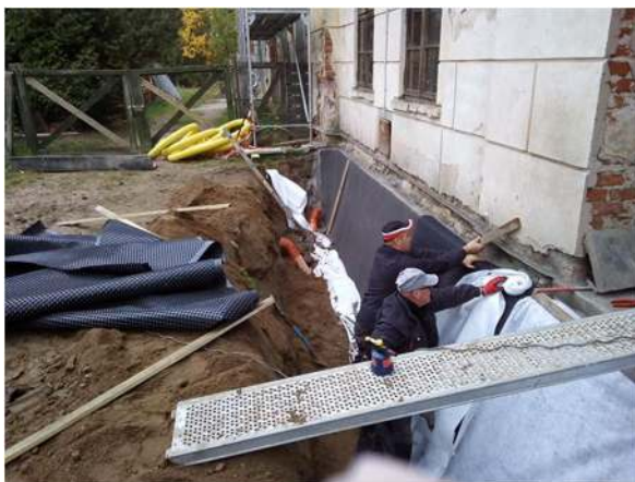
Bild 3 Einbau der Regenwasserkanalisation und der Drainage sowie der vertikalen Abdichtung am Ostflügel
