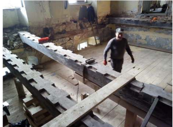
Bild 6 Arbeitsebene zum Ausbau der verbliebenen Balken über Raum 0.09 1
