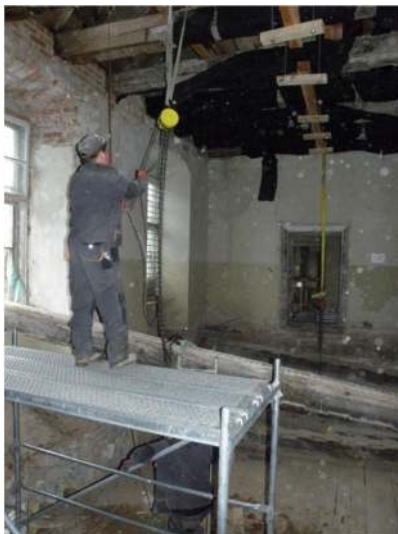
Bild 7 Ausheben eines Balkens durch das Fenster...
