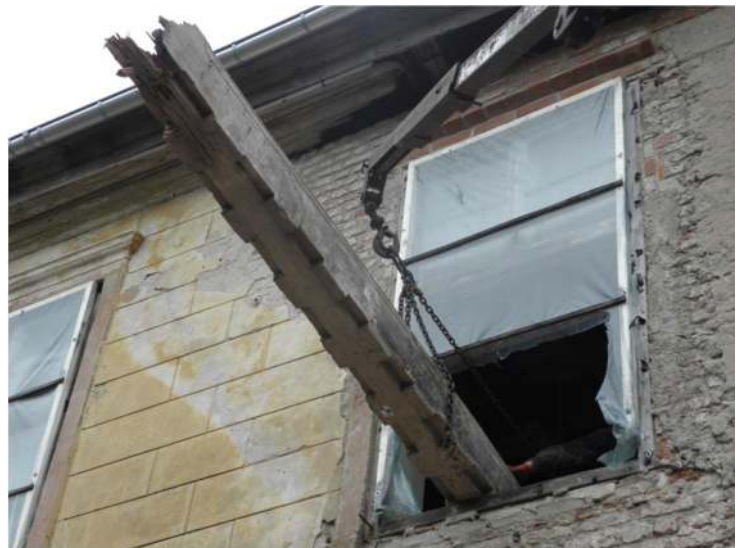
Bild 8 ...und Abnahme durch den Kran
