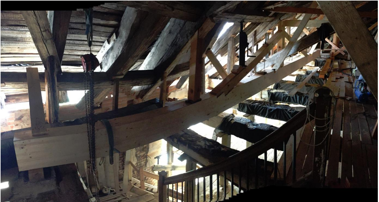
Das fertiggestellte Hängewerk an seiner endgültigen Position
